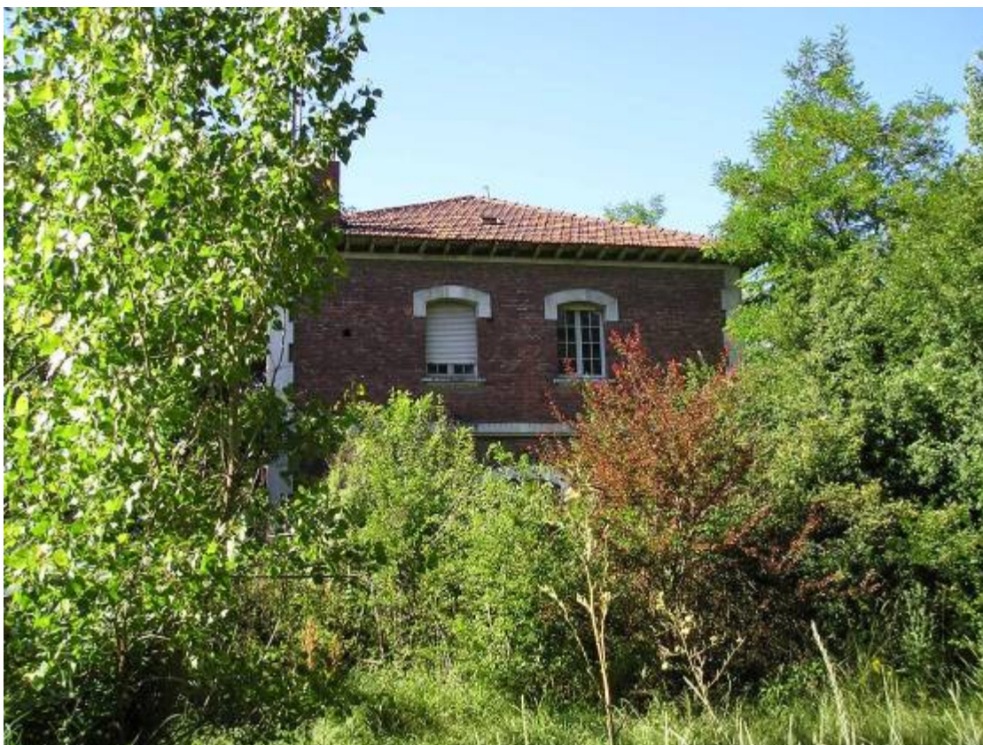
Fig. 3. Vivienda y jardín. Fachada norte
