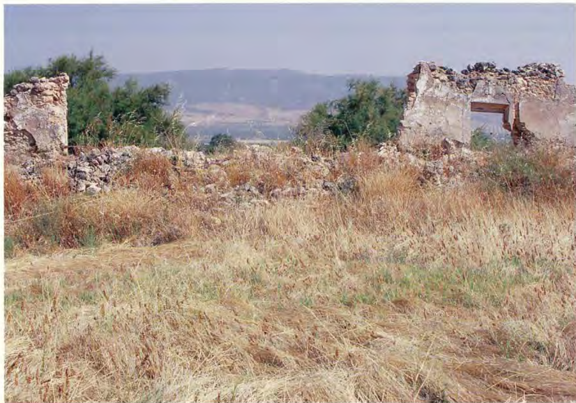
Figura 18. Restos de restos de las edificaciones de la lagunilla en Villarrubia de los Ojos (Ciudad Real).
